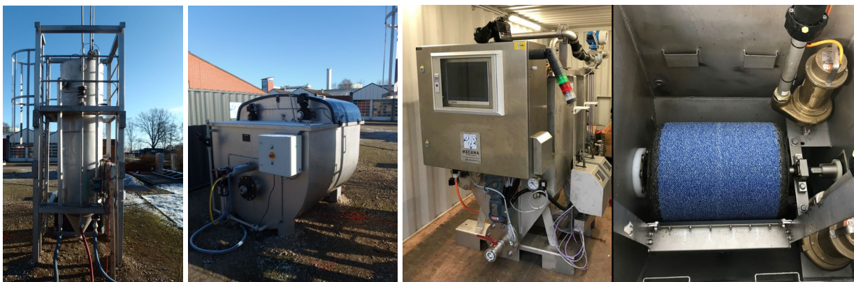
Abbildung 2-34: Nachgeschaltete Filtrationstechnologien: links: freistehender kontinuierlicher Sandfilter (DynaSand); Mitte: freistehendes Mikrosieb (DynaDisc); rechts: Frontansicht und Blick auf die Trommel des Polstofffilters
